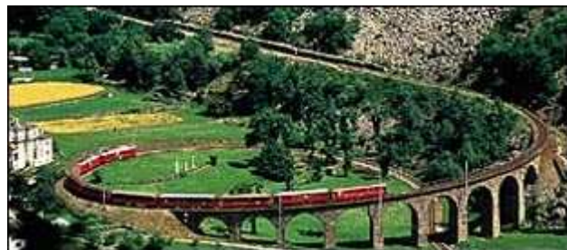
Viadotto elicoidale delle ferrovie retiche, Brusio, Grigioni
